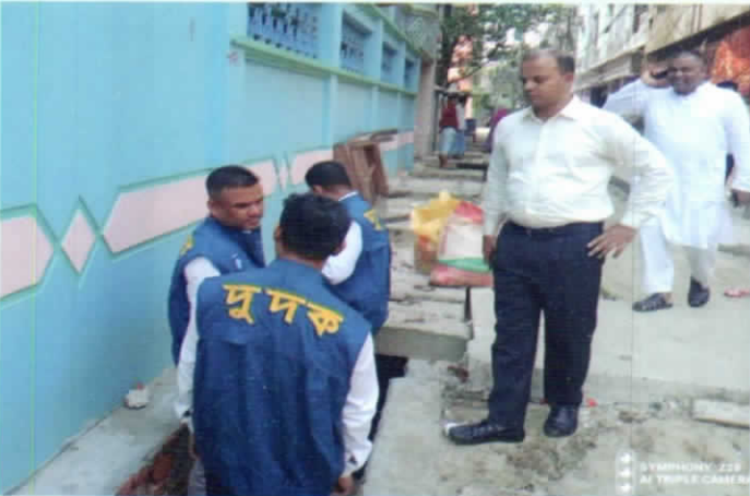
চট্টগ্রাম সিটি কর্পোরেশনের ডেন নির্মাণ কাজে অনিয়মের অভিযোগে এনফোর্সমেন্ট টিমের ঘটনাস্থল পরিদর্শন
